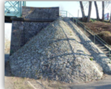
Culée en extrémité
