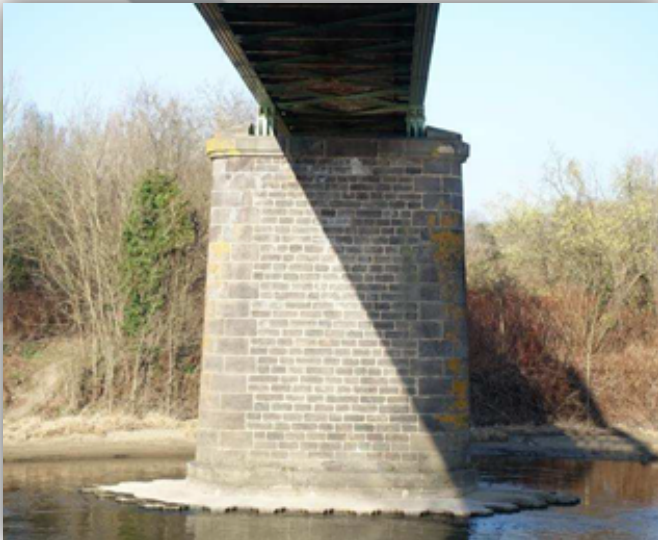
Pile du pont
