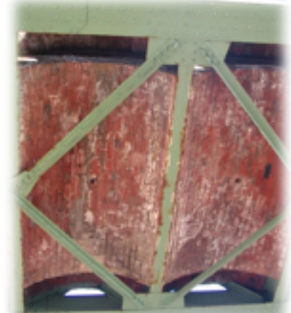
Voûtains en brique
